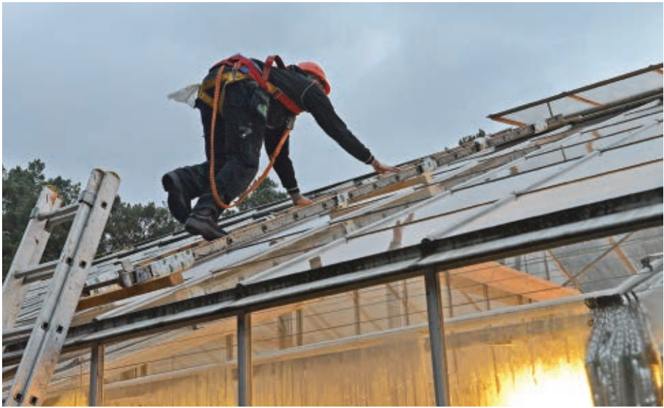
Glasstaket på Veksthuset byttes til polykarbonat (foto: Bjørn Moe, 16. november 2017).
