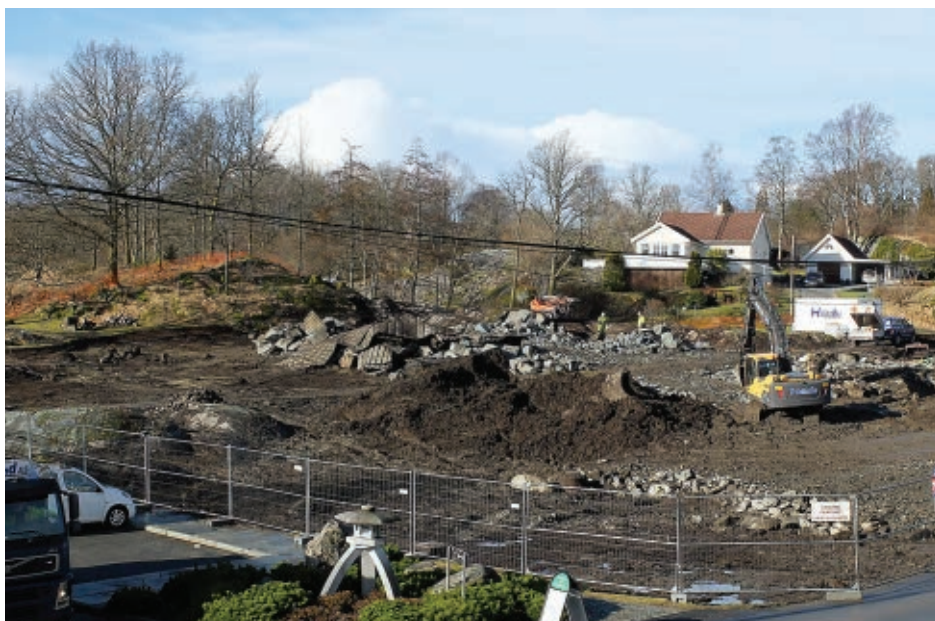
Tomten for reising av lystgårdsbuset fra Lønningen ble gravd ut og knausen der huset skal stå, ble sprengt ut (foto: Siri Skretting Jansen, 1. mars 2017).
