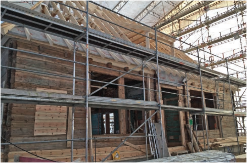
Under stillas og presenningtelt reiser tømmerveggene i det gamle lystgårdshuset seg (foto: Anne Hordnes, 21. desember 2017).
