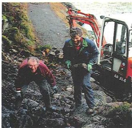
Jon Inge Kleveland og Alf Helge Søyland bygger veg i Kjempedalen (foto: T. Pousi).
